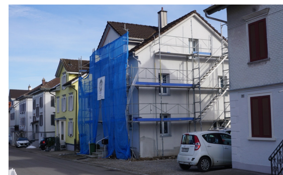
Energiesanierung: die Struktur bleibt erhalten
