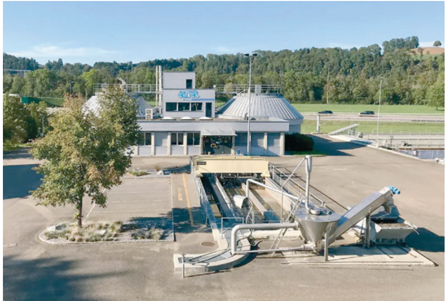
Am Standort der heutigen Uzwiler ARA soll die neue Grossanlage entstehen
