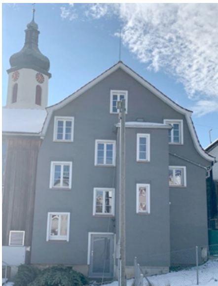
Nordfassade Neudorfstrasse 5, Kirchberg
