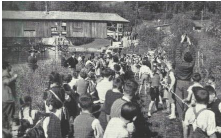
«Verschiebung» der alten Mühlau-Thurbrücke am 9. Mai 1952 durch die Schuljugend von Bazenheid und Lütisburg zwecks Ermöglichung des projektierten Neubaues.
