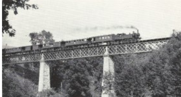
Alte Eisenbahnbrücke bei Bazenheid Erbaut 1868 – 1870, Verstärkung der Eisenkonstruktion 1897
