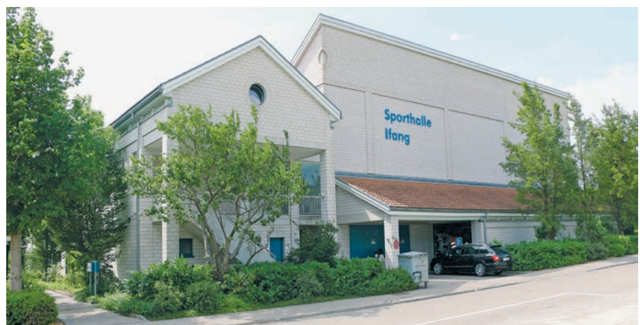
Mehrzweckgebäude Ifang, Bazenheid
