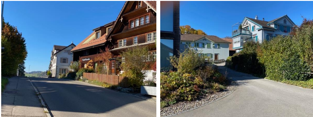
Ortsausgang an der Schalkhusenstrasse (18, 18a und 20) in Verbindung mit dem gegenüberliegenden Baumbestand und Blick auf das Ensemble Sonnengrundweg 5 und 7 (Ehemalige Stickereifachschule).
