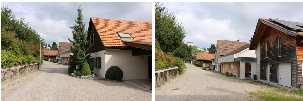
Der Raum der Kirchgasse wird durch den Friedhof und seine Einfriedung (hangseitig) und lange, kombinierte Baukörper (talseitig) geprägt.
