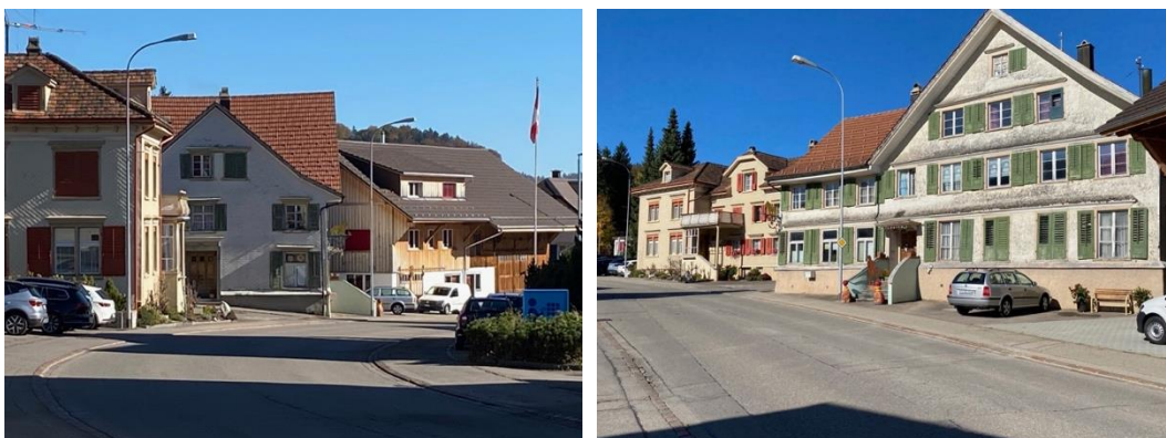
Baugruppe mit dem Gasthaus Löwen und der grossen Scheune: Sie dominieren den Beginn des Ortskerns von Osten.
