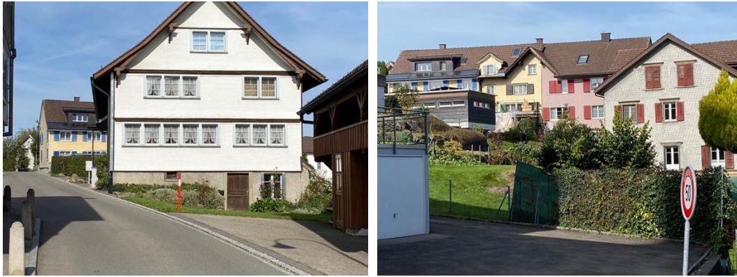
Blick in die Rätenbergstrasse und Durchblick auf die Häusergruppe aus der Neudorfstrasse
