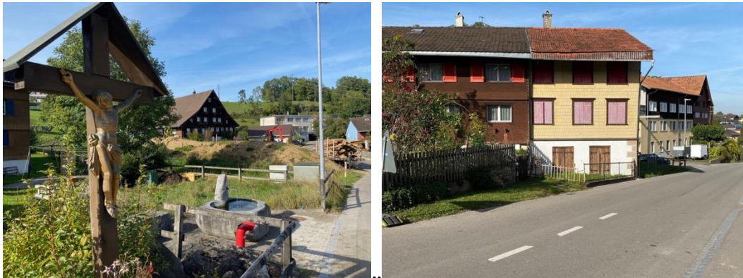
Mitte des Weilers: der offene Bachlauf, Brunnen und Wegkreuz. Ausgang des Weilers talseitig: Doppelhaus übereck zum Strassenverlauf, ein willkommener Abschluss des Nuetenbachrings. Sollte erhalten bleiben.
