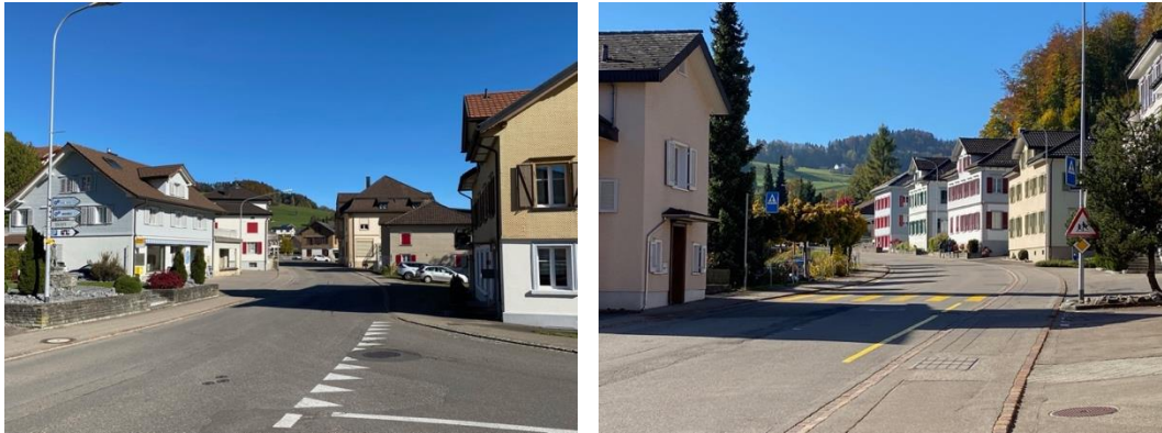
Ortseingang von Westen und Häuserzeile an der Hulfteggstrasse - Ortsausgang Richtung Hultegg.
