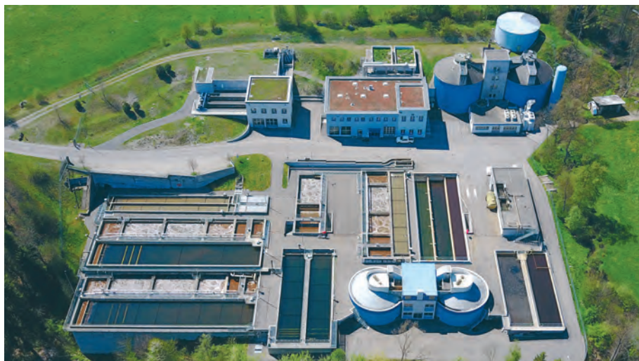
Die Abwasserreinigungsanlage Bazenheid
