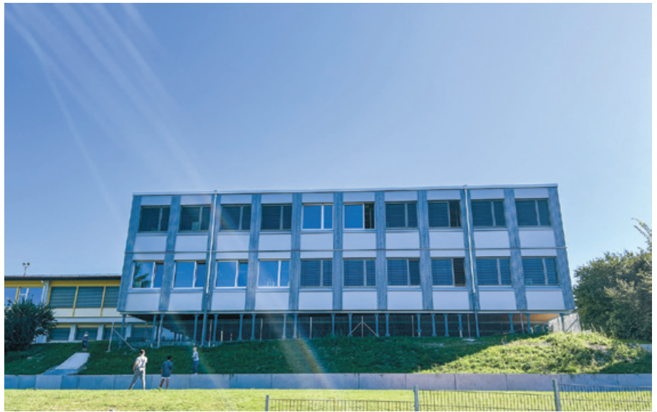
Das neue Schulraumprovisorium der Primarschule Sonnenhof
