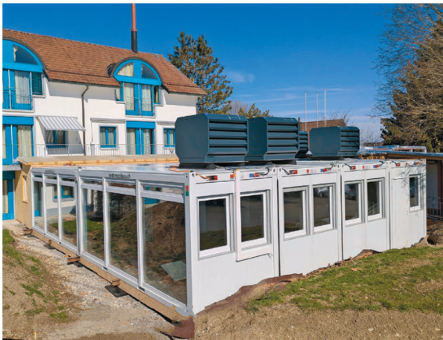
Die gestellten Container werden während der Bauarbeiten als Provisorium für die Küche und das Restaurant des Sonnegrund dienen.
