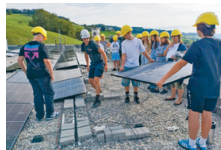
Bei der Installation der PV-Anlagen auf der Turnhalle in Gähwil durften die Schülerinnen und Schüler selbst Hand anlegen.
