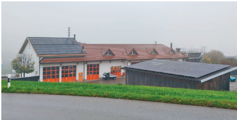
Die beiden PV-Anlagen auf dem Unterstand und der Salzhalle des Werkhofs Husen
