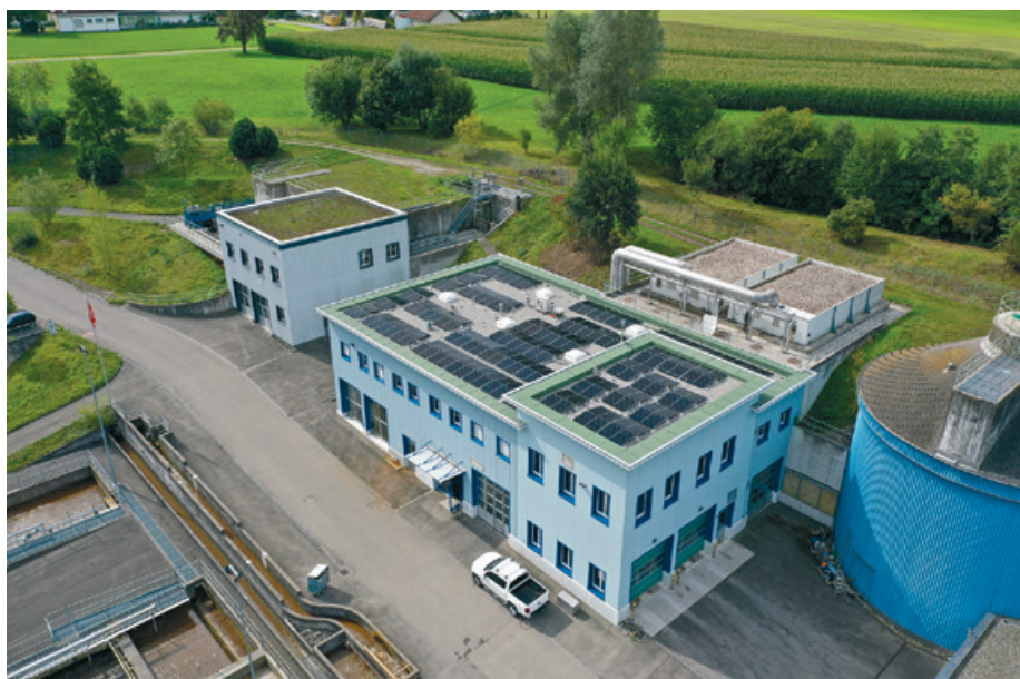
Das sanierte Dach des Betriebsgebäudes mit neuer PV-Anlage
