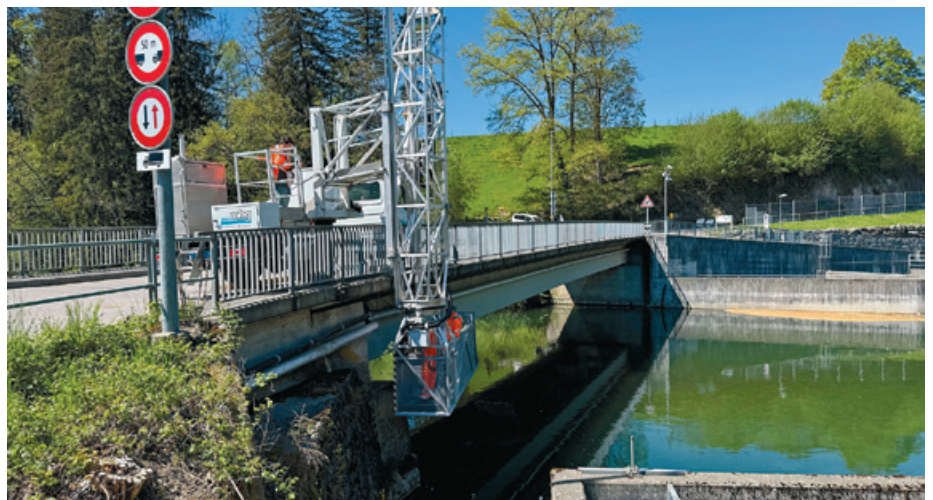
Am 30. April 2026 wurde eine spezialisierte Zustandsbeurteilung der Mühlaubücke mit Inspektion vor Ort durchgeführt.
