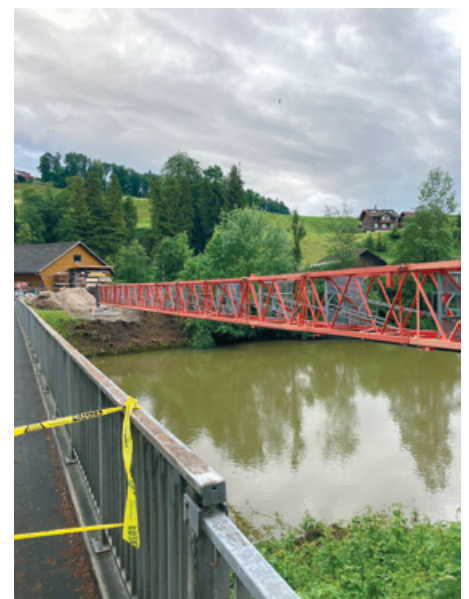
Am 10. Juni 2026 konnte eine provisorische Rohrleitungsbrücke über die Thur gelegt werden.
