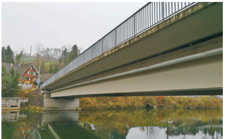
Das Ersatzneubauprojekt der Mühlaubücke kann weiterverfolgt werden.
