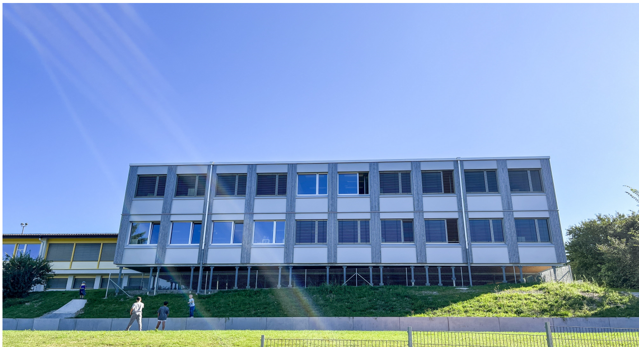
Das neue Schulraumprovisorium der Primarschule Sonnenhof
