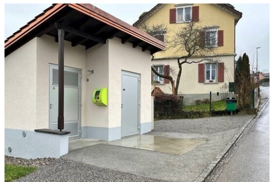
Trafostation, Chogelhuetstrasse, Müselbach
